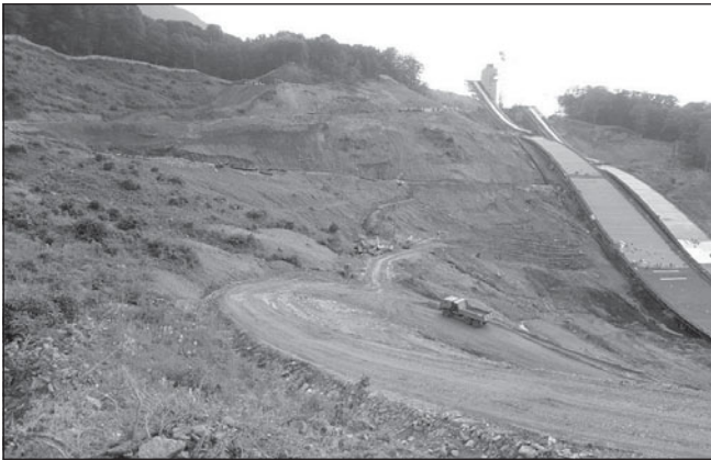
Рис. 3. Комплекс трамплинов К-125 и К-95 в период строительства (г. Сочи)
