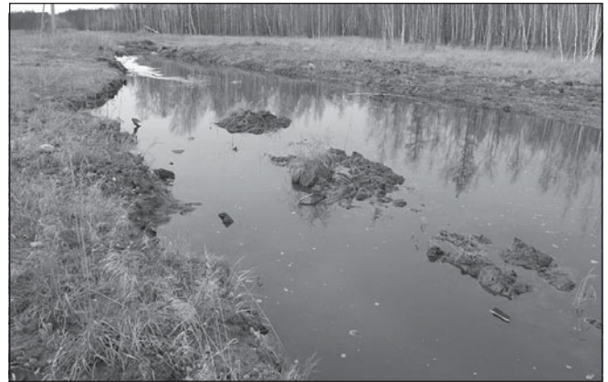
Рис. 4. Развитие термокарста на трассе подземной прокладки нефтепровода
