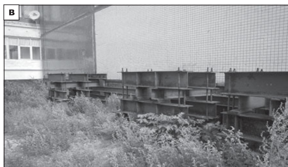
Рис. 2. Аварийная ситуация с панельными зданиями, построенными по проектной документации повторного применения на закарстованной карбонатной толще с доломитовой мукой в пос. Серноводск Самарской обл.
